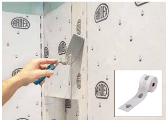
ARDEX SK 12 TRICOM Dichtband verkleben
