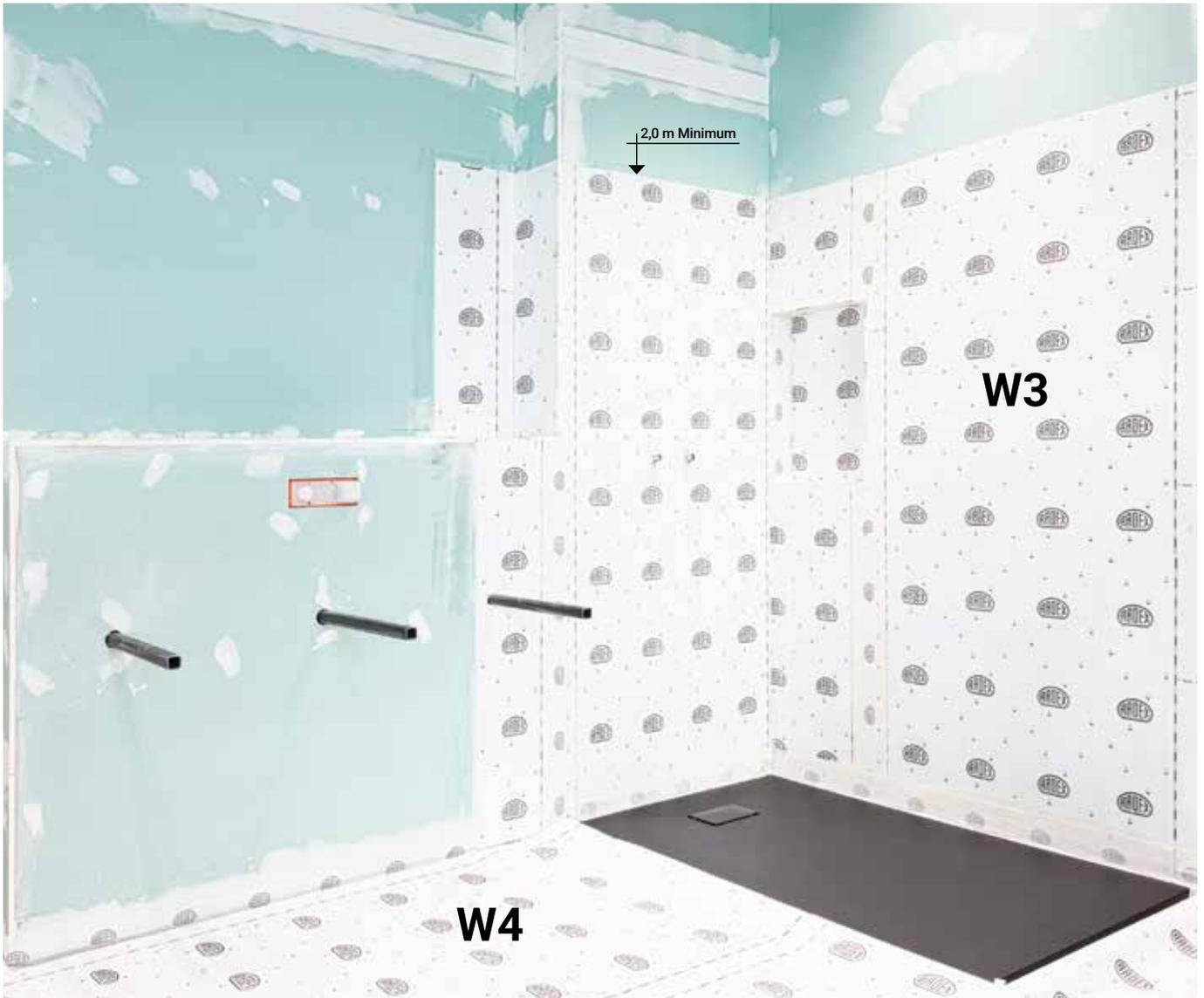
Vollständig ausgeführte Abdichtung: Duscbereich W3, Boden W4
