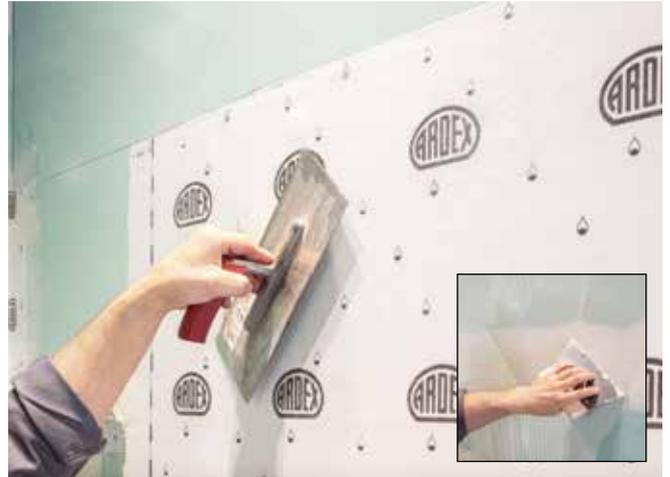
ARDEX SK 100 W TRICOM Dichtbahn verkleben
