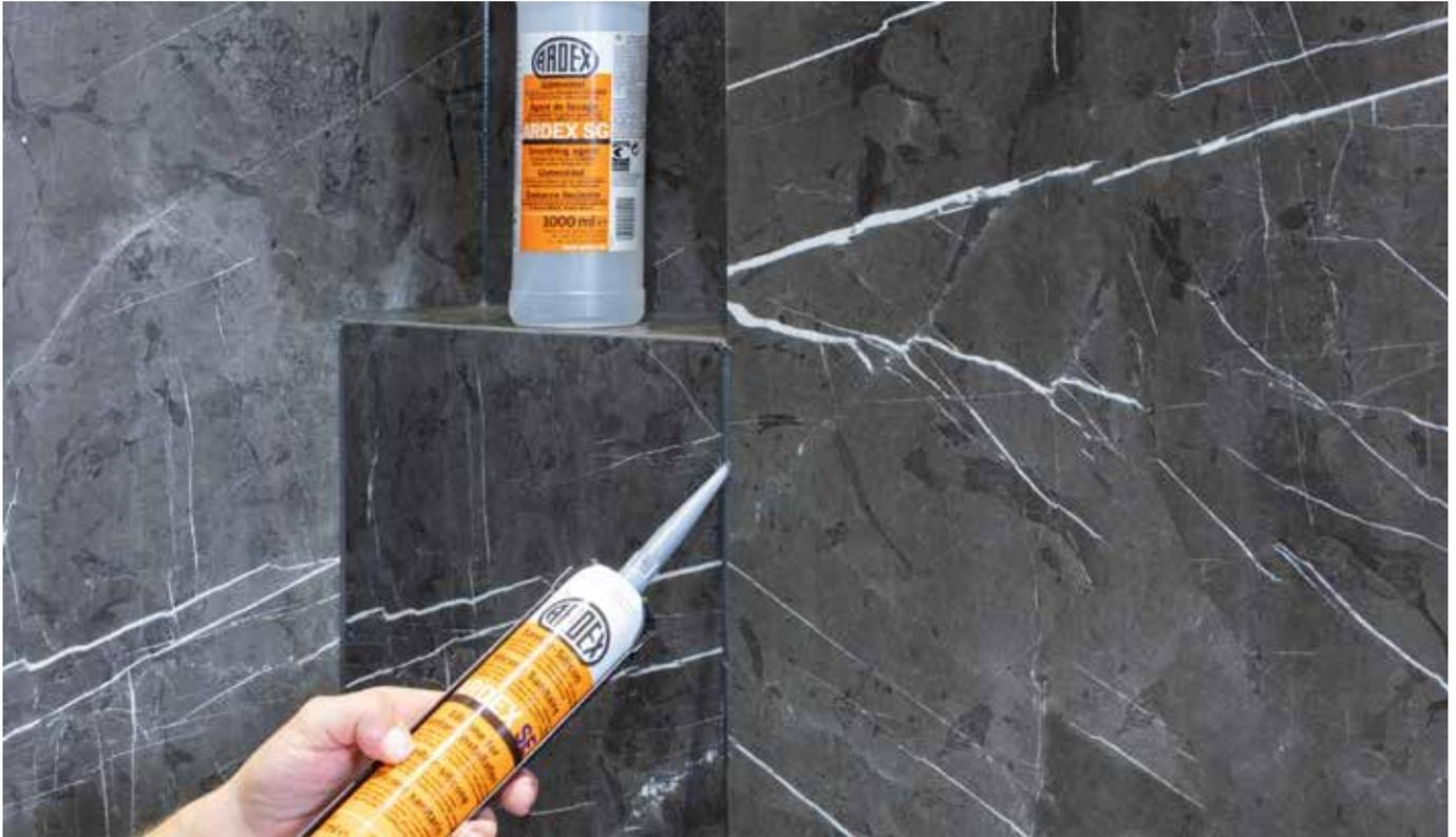
Bringen Sie ARDEX SE Sanitärsilikon mittels Kartuschenpresse in die Fuge ein
