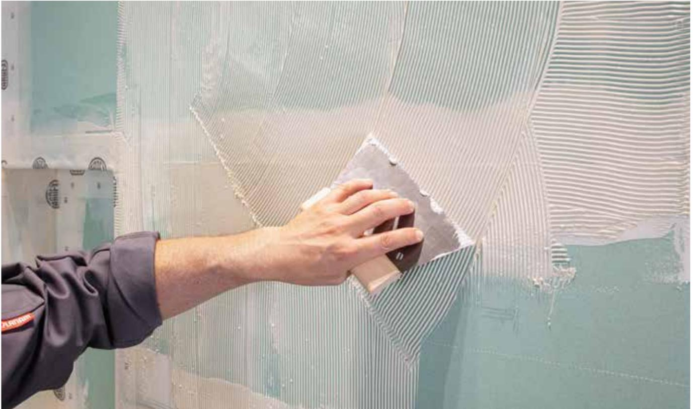
Kleber ARDEX AF 181 W mit Zahnschachtel (B2) auftragen und ca. 10 Minuten ablüften lassen
