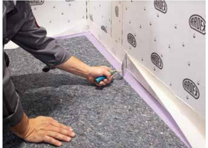
ARDEX SK 12 BT Wannendichtband an Wand verkleben
